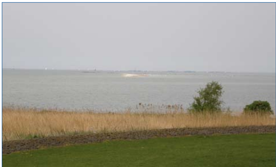
De zandmotor bij Hindeloopen bestaat uit een paaltjesdam en zandsuppleties.
