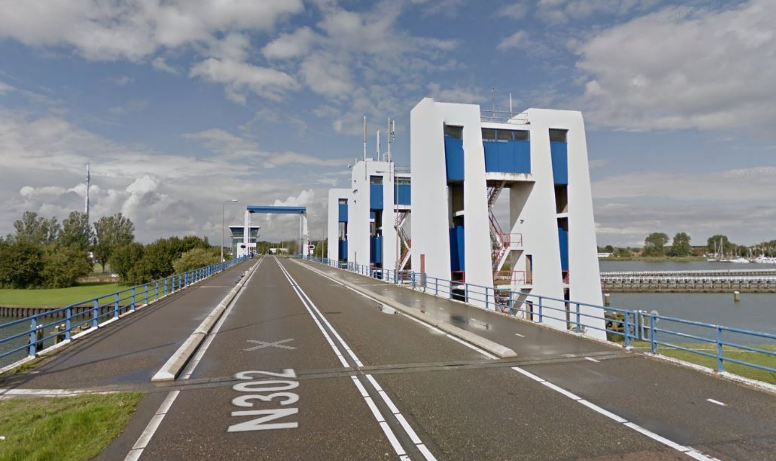
Figuur 2.2 Krabbegatsluizen (bron: google streetview)
